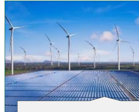
Sistema de Almacenamiento de Energía
