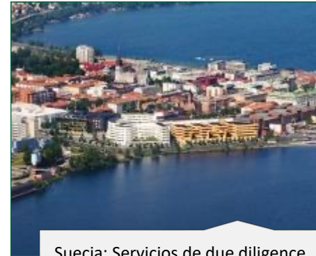
Suecia: Servicios de due diligence de activos de distribución para un comprador
